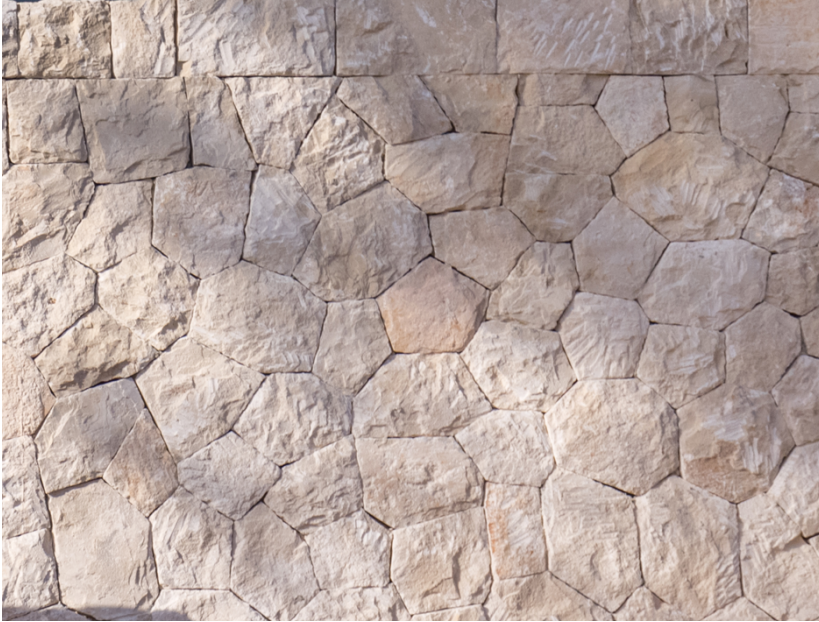
Muros de mampostería de piedra caliza
